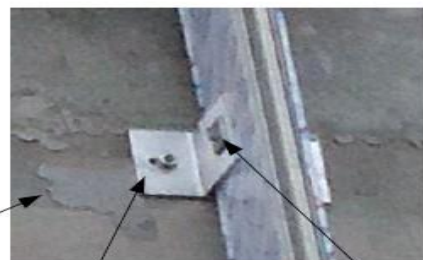
طريقه تركيب البراكت الالومنيوم بالبلاطه الخرسانيه
